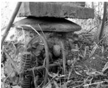
*Рис. 1. Дефектный железобетонный фундамент ВЛ 500 кВ*
