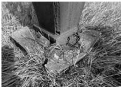
*Рис. 2. Состояние ранее отремонтированного фундамента*
