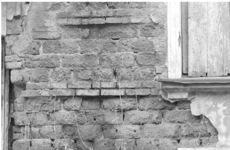
*Рис. 5а. Смешанная кладка с перевязкой швов из кирпича через 4 ряда шлакоблоков*
