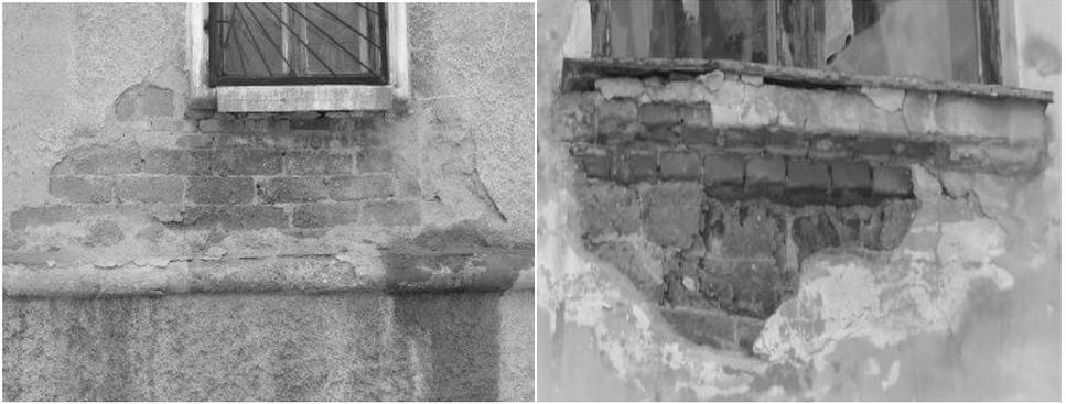
*Рис. 6а. Смешанная кладка в месте опирания оконного блока усилена кирпичом*
