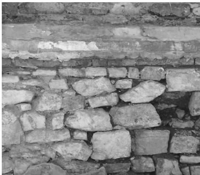
*Рис. 6д. Смешанная кладка при переходе от фундамента к основной стене в цокольной части усилена кирпичом*
