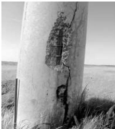
*Рис. 3. Дефектная железобетонная стойка ВЛ 110 кВ*
