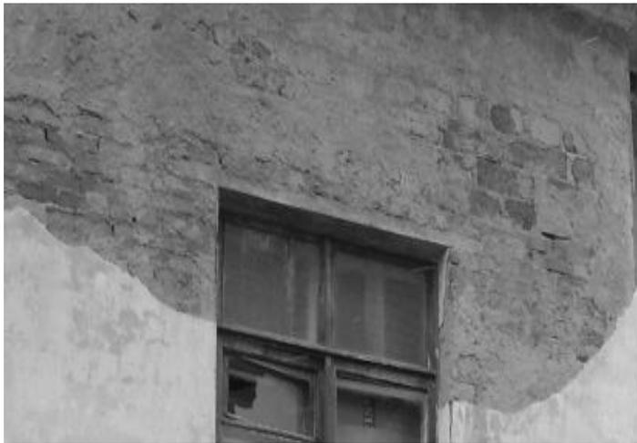
*Рис. 6б. Опирание на кирпич перемычки*
