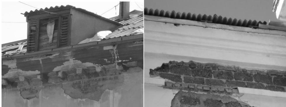
*Рис. 6г. Опирание конструкций крыши на кирпич*
