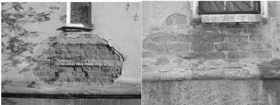
*Рис. 5б. Смешанная кладка с перевязкой швов из кирпича через 3 ряда шлакоблоков*
