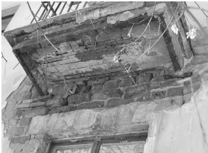
*Рис. 6в. «Слабое» место опирания балконной плиты усилено прочным кирпичом*
