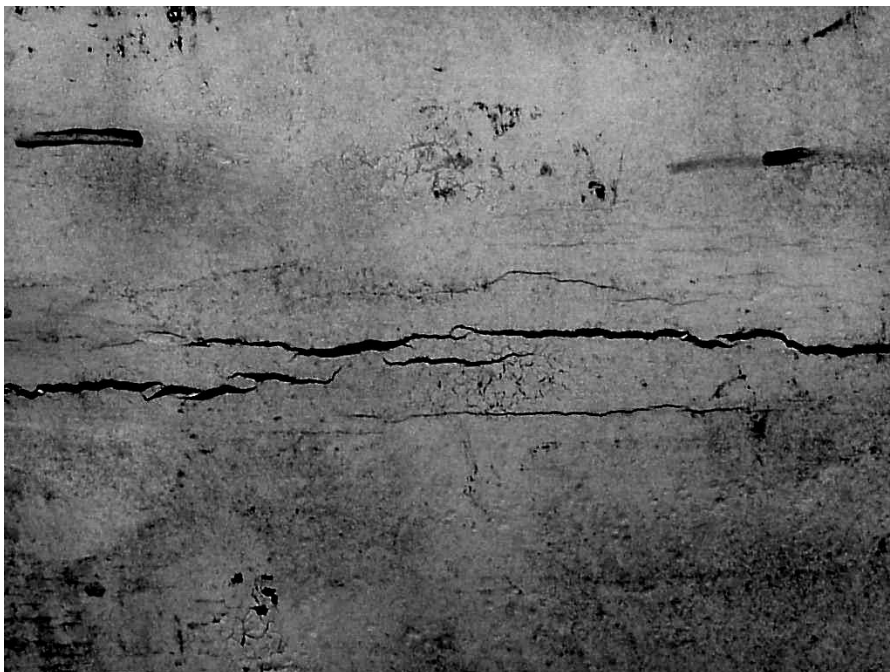
Рис. 1. Участок со стресс-коррозионными трещинами
