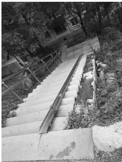
*Рис. 2. Обвалившееся пандусное устройство на остановке «Картинная галерея»*
