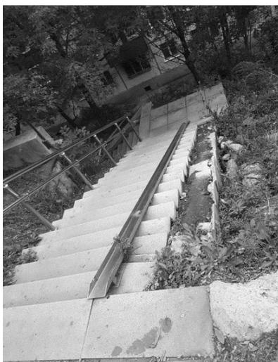
*Рис. 2. Обвалившееся пандусное устройство на остановке «Картинная галерея»*
