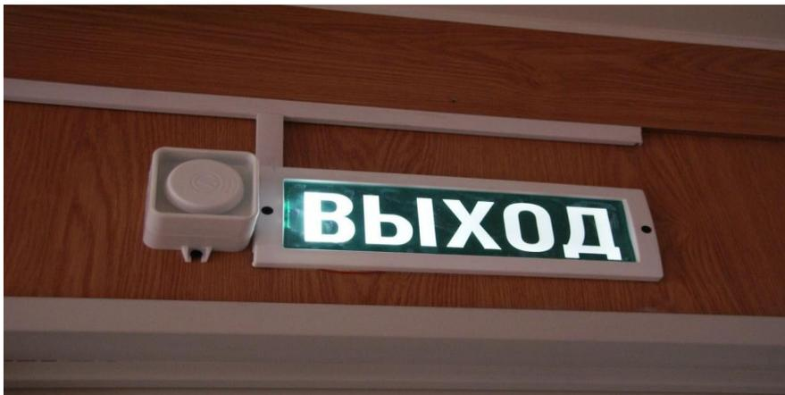
Рис. 1 Указатели эвакуации аварийного освещения
